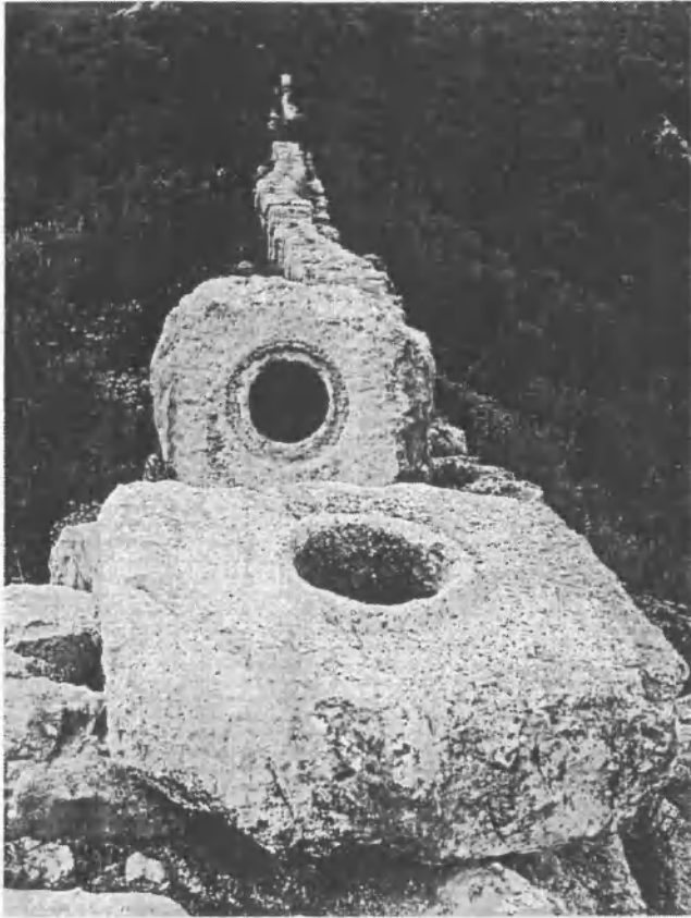
Abb. 23 Druckröhre von Norden in Fließrichtung
