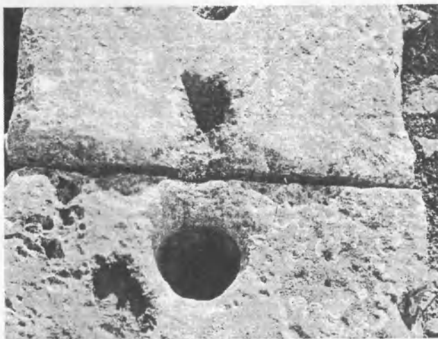
Abb. 36 Steinrohrglieder mit Entlüftungsloch und Klammerloch
