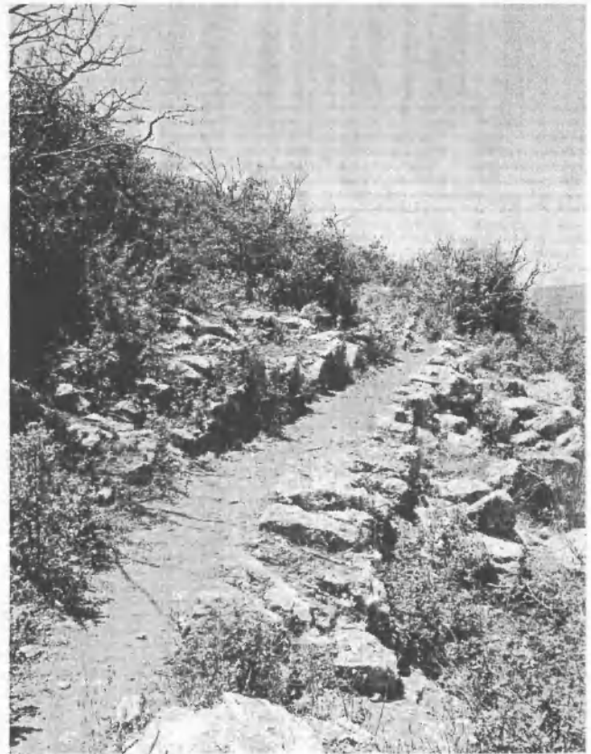
Abb. 26 Wasserleitungstrasse zwischen Firnaz und Delikkemer
