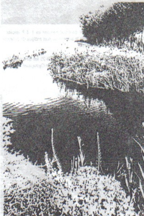
-Le canal Şamram, de 56 km de longueur, amenant 2-3 m 3 /s d'eau au capital ourartien Touchpa (Vanikale), construit en 800 av. J.C. et qui sert encore à irriguer quelques milliers d'hectares.
