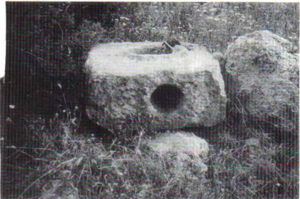
1 b. Patara: stone pipe block with bottom outlet (?) (Fahlbusch)
