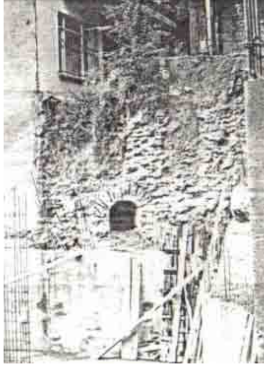
Hacı Hasan mahallesi, İnönü cad. 21 parseldeki temel içinde su yolu
