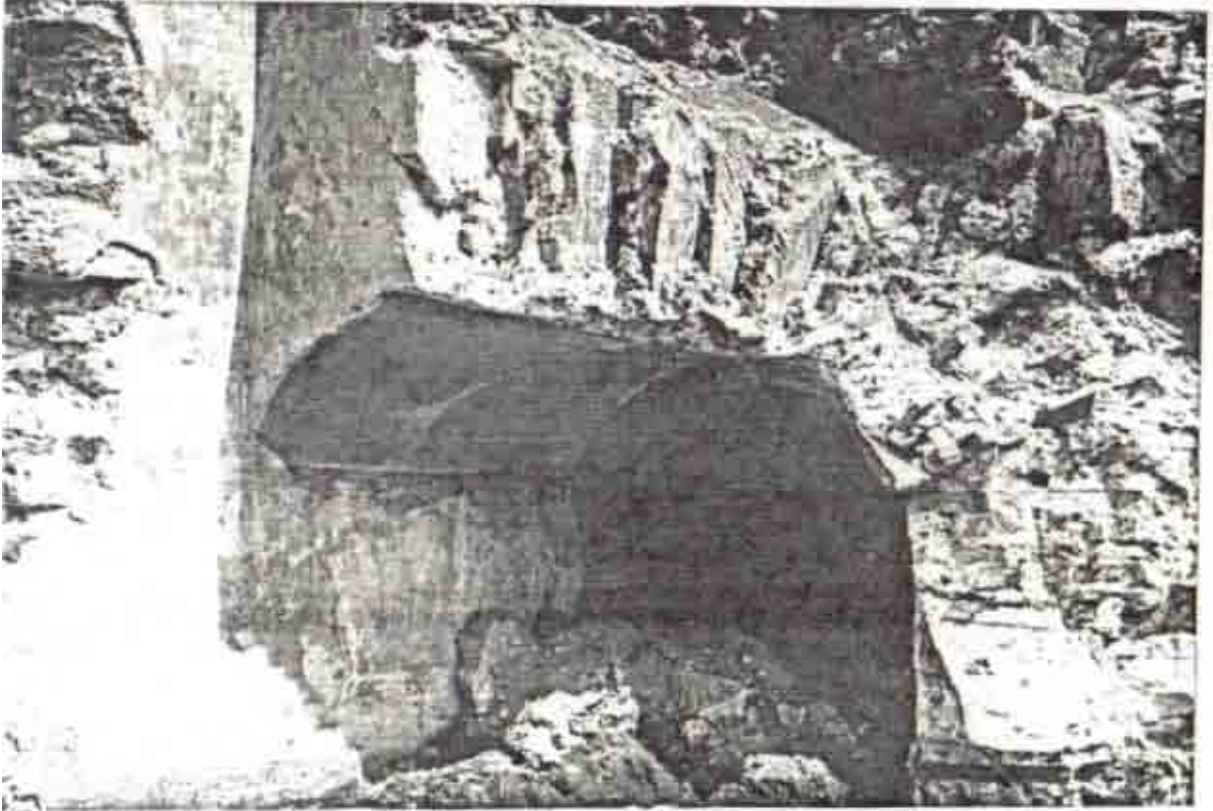
Hacı Hasan mahallesi-İnönü Caddesinde-21 Parseldeki inşaatın temel içinde kalan su yolu
