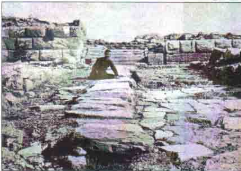
Abb. 23: Abgedeckter Entwässerungskanal in der Quellentorstraße (nach Wiegand – Schrader Abb. 43, S. 75).
