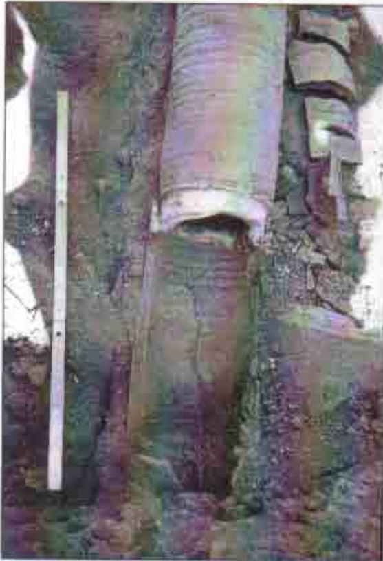
Abb. 12: „Geriffeltes“ Tonrohr mit vermörteltem Stoß (Foto: Hupka).
