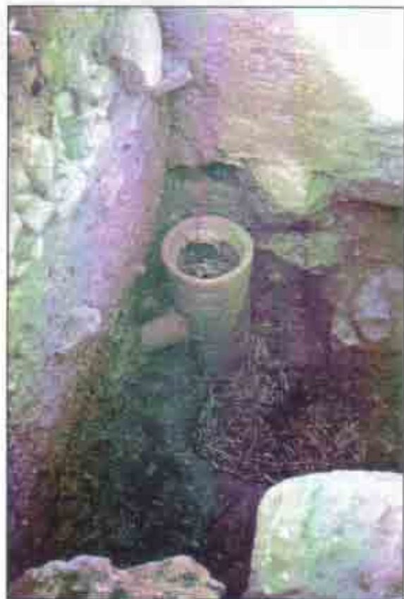
Abb. 16: Vertikales Rohr als Richtungsänderungselement in Sondage F 15 mit gleichzeitiger Funktion als „Absturzschaht“ (Foto: Hupka).
