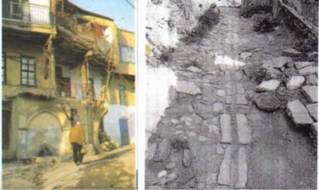
Ak mahallede bir eşme, taş dşeme yollarda yaėmur suyu kanalı (saėda)
