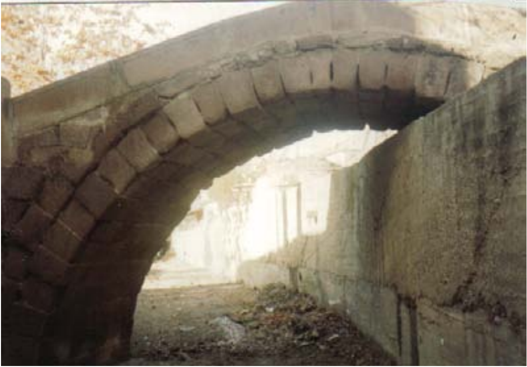
Ünlü taş köprünün kemer yapısı
