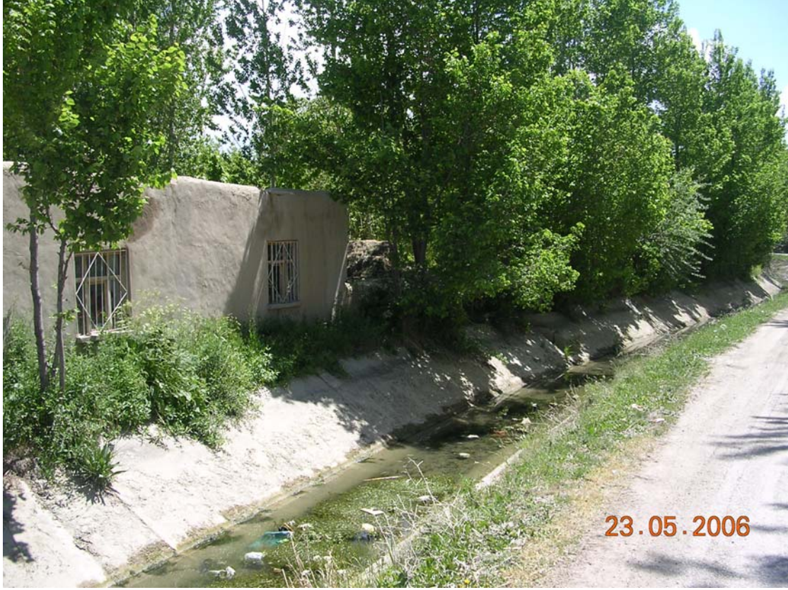
Edremit içinde Şamran kanalı
